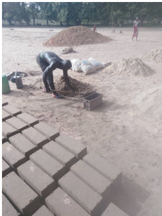
Bakstenen voor de fundering van de laatste 3 klaslokalen
